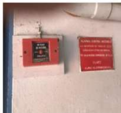
ESTACION MANUAL CEPESA 2
